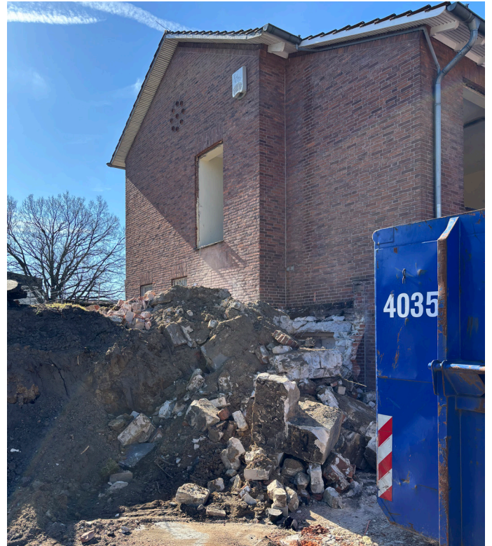
Totalabbruch Vorbau Heizungsraum Eingangsfassade
