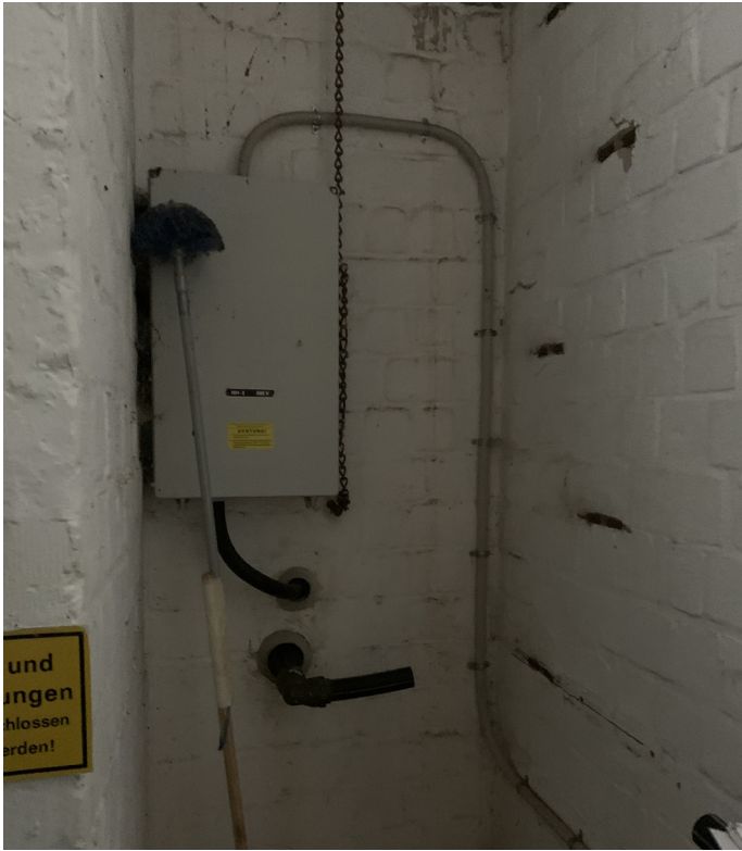
Hausanschluss Strom
